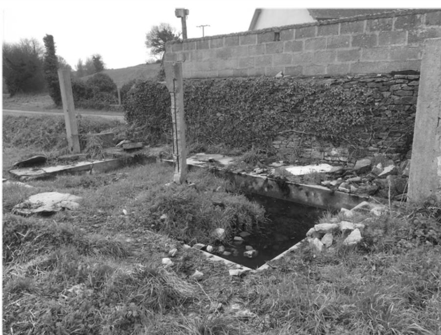
Le lavoir de Kerouen semble assez ancien par rapport au mur de pierre et des dalles de pierre composant son pourtour. Le mur de parpaings a été monté dans les années 50. Il servait, avec les 3 poteaux, de support au toit afin de protéger les lavandières.
