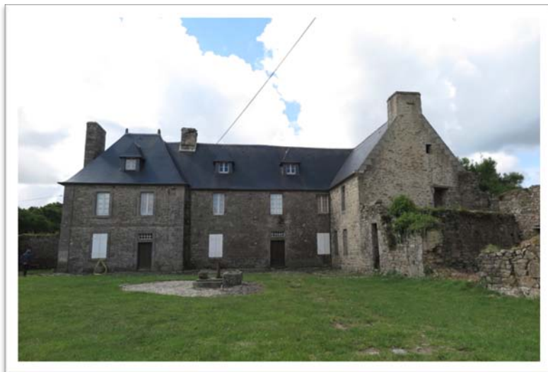
Le manoir de Kerdrel – façade NORD
