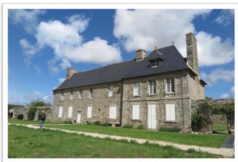
Le manoir de Kerdrel – façade SUD
